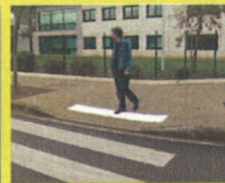
Dalle podotactile extérieure (BEV)
